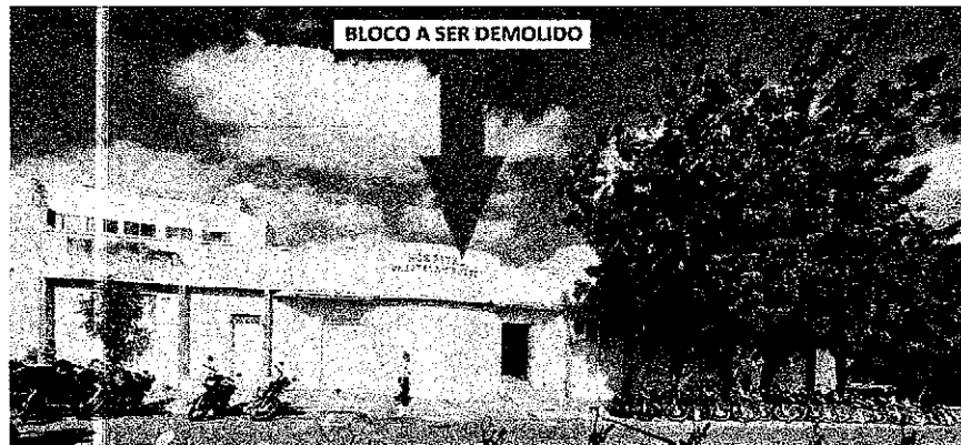
Fig. 03 – Vista externa do atual bloco que deverá ser igualmente demolido
