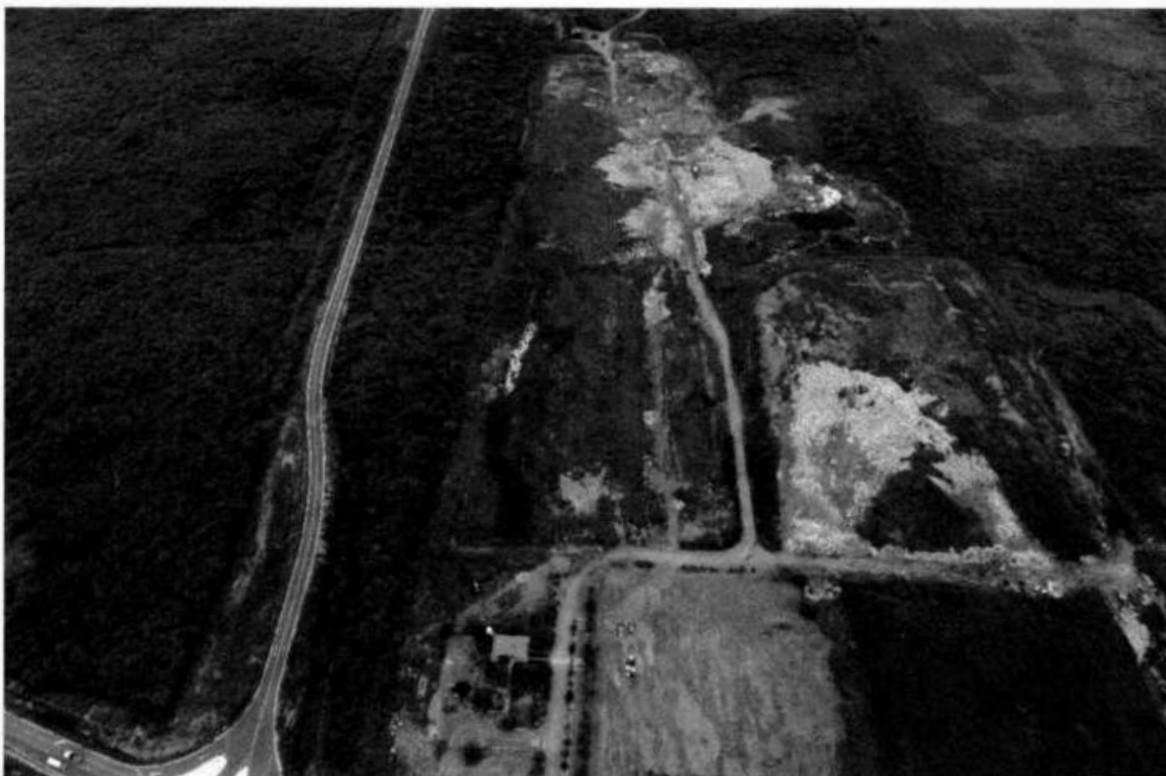
FIGURA 2.7 – ATERRO SANITÁRIO EXISTENTE
