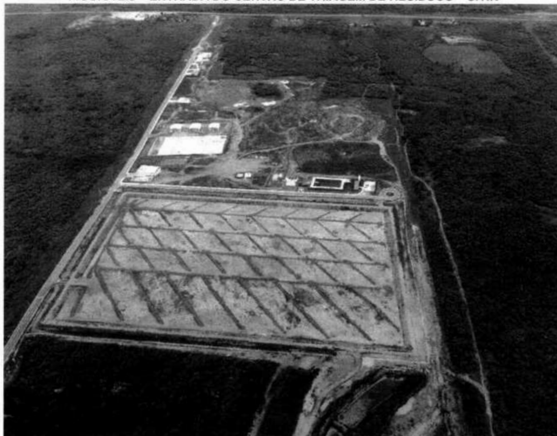
FIGURA 2.9 – VISTA AÉREA DO CENTRO DE TRIAGEM DE RESÍDUOS
