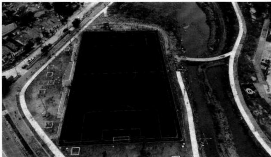
FIGURA 2.25 – ARENINHA NO PARQUE PAJEÚ (LAGOA DA FAZENDA) – EM CONSTRUÇÃO
