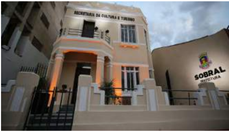
Restauração da nova sede da Secult.
