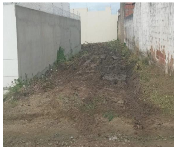
Imagem 02: situação do terreno após limpeza.
