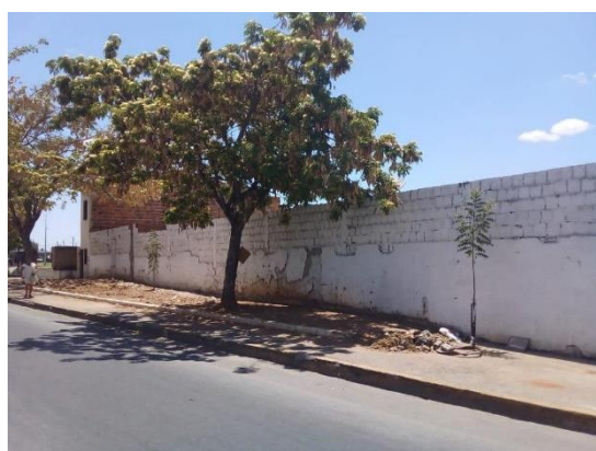
Imagem 05: ponto inadequado de lixo
