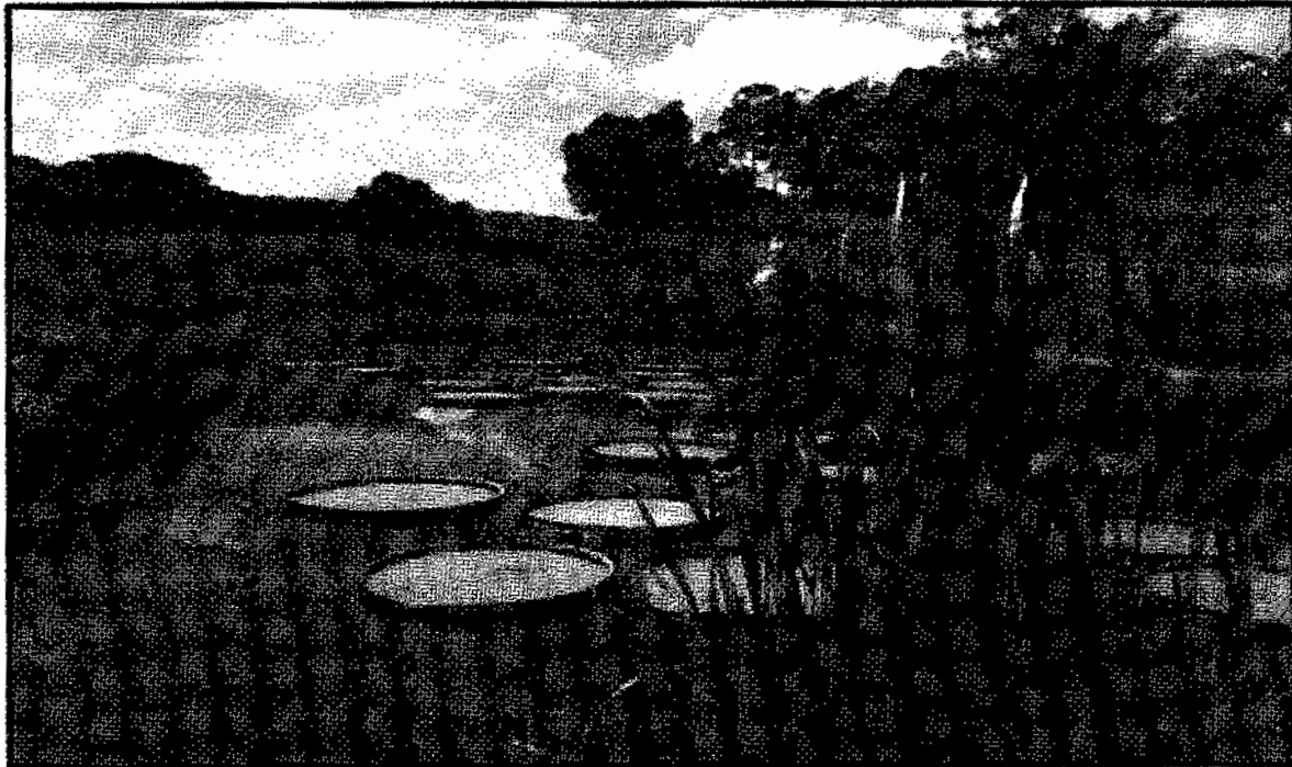
SACs Para Tratamento de Efluentes Agroindustriais em primeiro plano se observa a Lagoa Final ao fundo, SACs linear – Itatiba – S.P. – 2009
