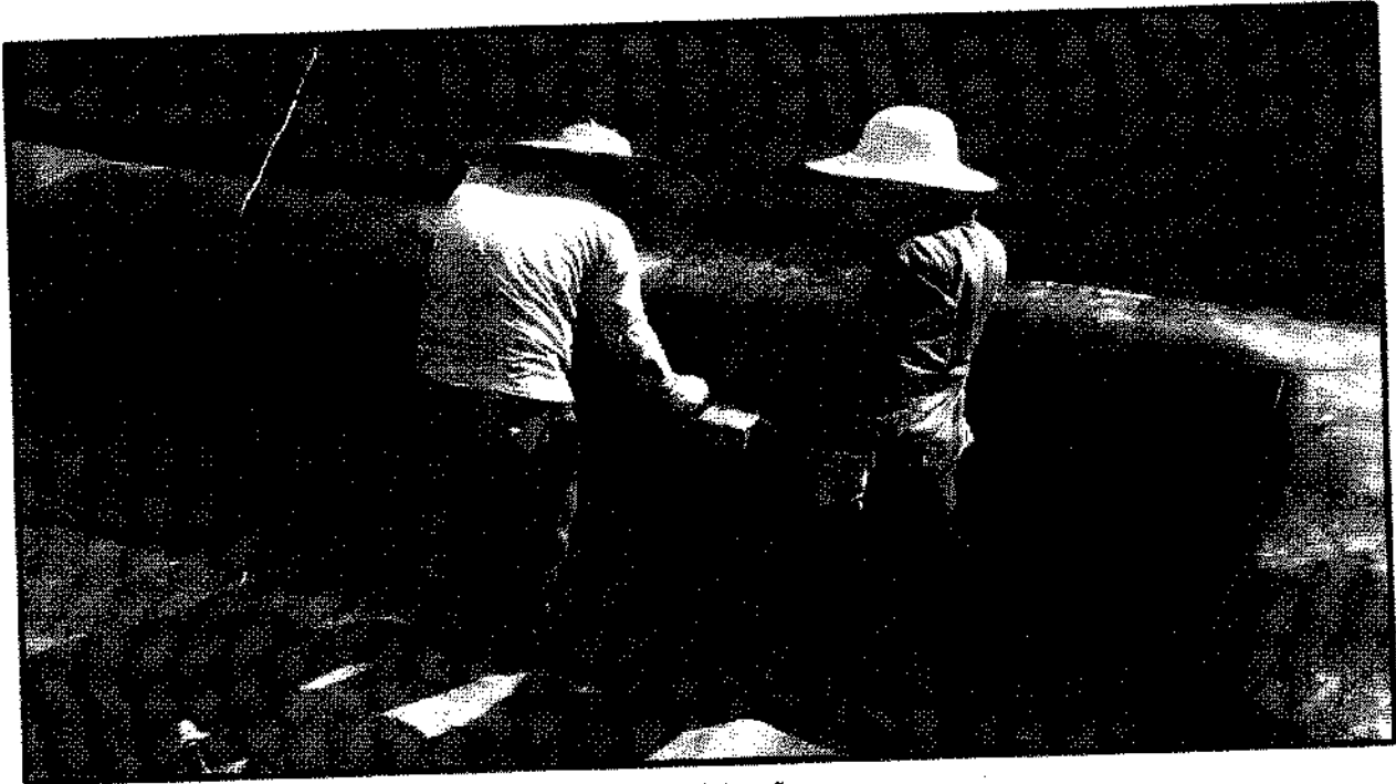
Exemplo de ancoragem e soldagem da manta de impermeabilização
