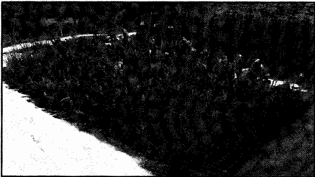
SACs – Em pós tratamento de Efluentes Domésticos – 45 dias após plantio – Mairiporã- S.P. -2014
