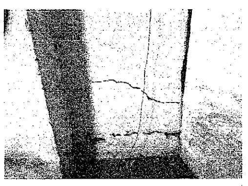
FOTO 28 – TRINCA EM PAREDE Fonte: Autoria Própria.
