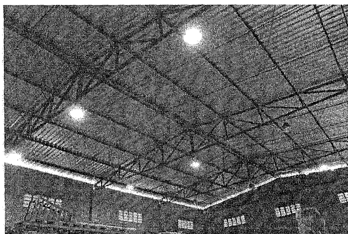
Cobertura do galpão 01
