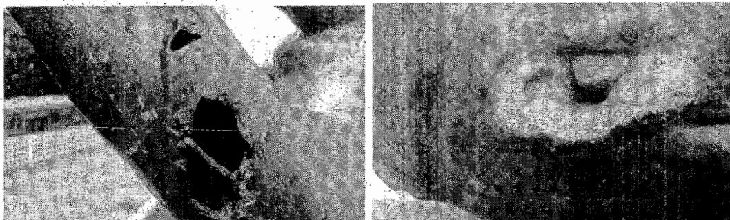
Detalhes da rede de fissuras provocadas pela alternância de calor e umidade na obra.
