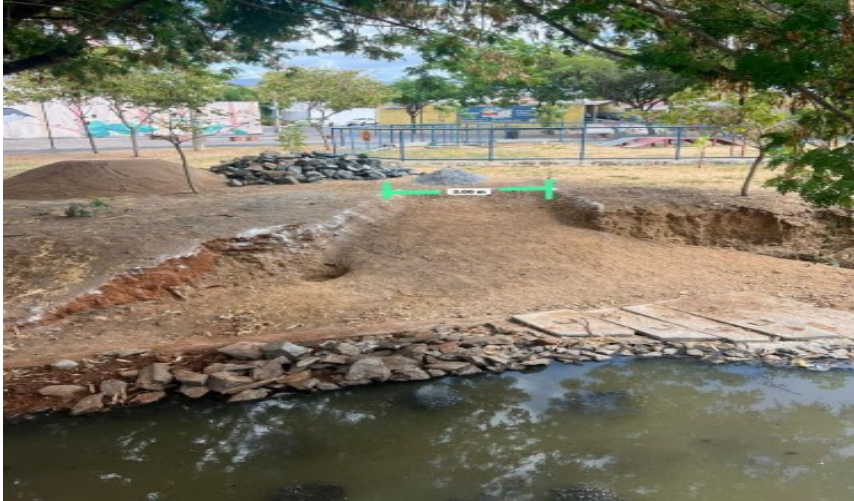
Figura 3: Abertura de acesso para limpeza mecanizada na Caixa de Areia do Sistema de Jardins Biofiltrantes do Riacho Pajeú
