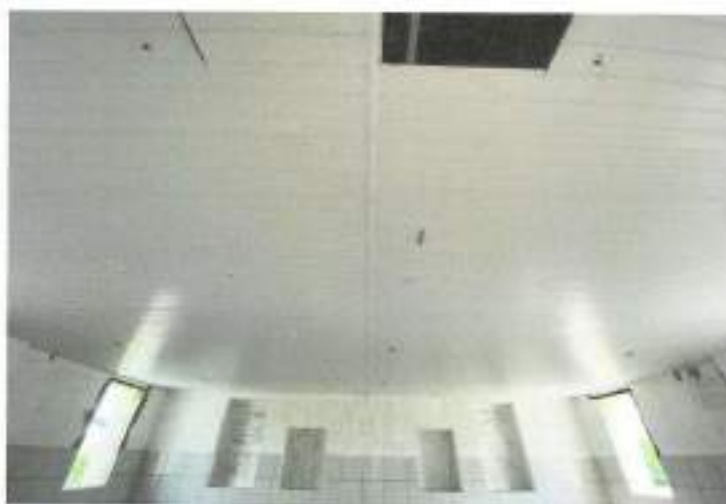
FOTO 09: DEMOLIÇÃO DE FORRO EM PVC NO REFEITÓRIO (SUPERIOR)
