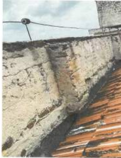
FOTO 01: PLATIBANDA A RECEBER REBOCO E CHAPIM
