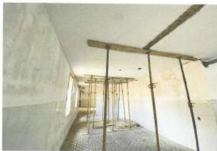
FOTO 04: REFORÇO ESTRUTURAL EM VIGAS METÁLICAS
