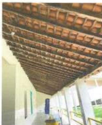
FOTO 06: APLICAÇÃO DE VERNIZ EM EMADERAMENTO DA COBERTA DO PÁTIO
