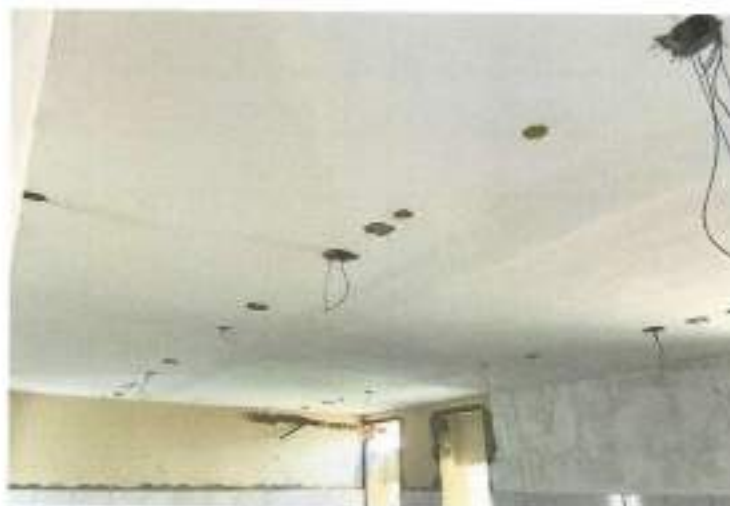
FOTO 08: APLICAÇÃO DE GESSO ACARTONADO
