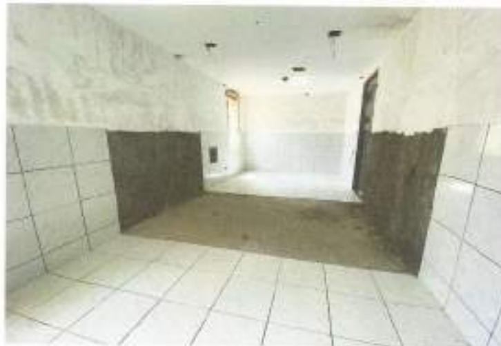
FOTO 02: ALOJAMENTOS A RECEBER PAREDE HIDROFUGANTE NOS ALOJAMENTOS
