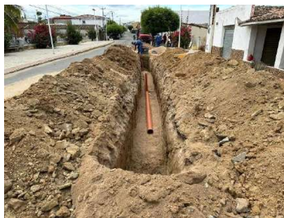
Figura 63 - Ampliação da rede de esgotamento sanitário no distrito de Aracatiaçu.
