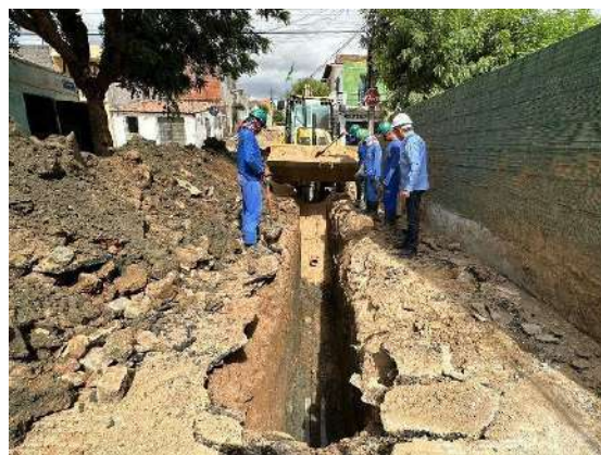
Figura 61 - Ampliação da rede de esgotamento sanitário no bairro José Euclides.
