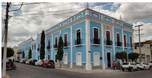
Figura 31 - Pintura da fachada do Museu Dom José.
