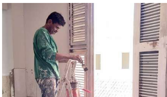
Figura 34 - Pintura nova de esquadria do Abrigo.
