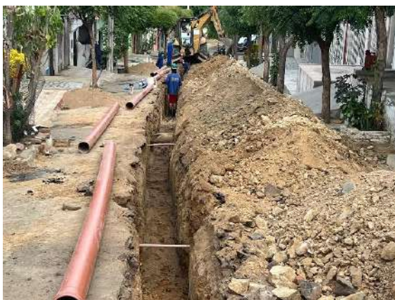
Figura 60 - Ampliação da rede de esgotamento sanitário no bairro Dom José.
