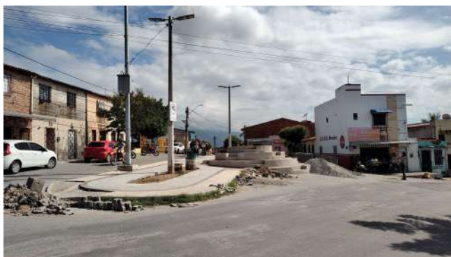
Figura 8 - Obra do Projeto Piloto no bairro Sumaré.
