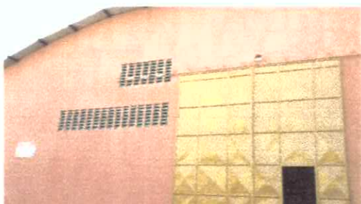
Foto 03: Ventilação fachada
