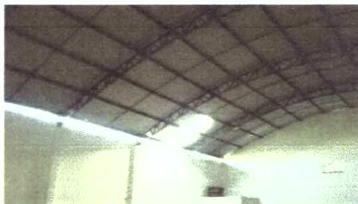
Foto 05: Estrutura metálica e coberta
