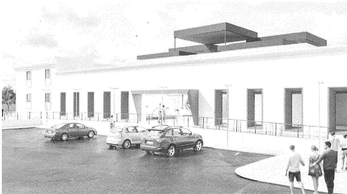
Figura 1 – Vista do empreendimento Cadeia Criativa: bloco do edifício histórico com dois pavimentos, bloco novo de entrada comercial com pórtico em aço corten e, ao fundo, vista da coberta do átrio central.
