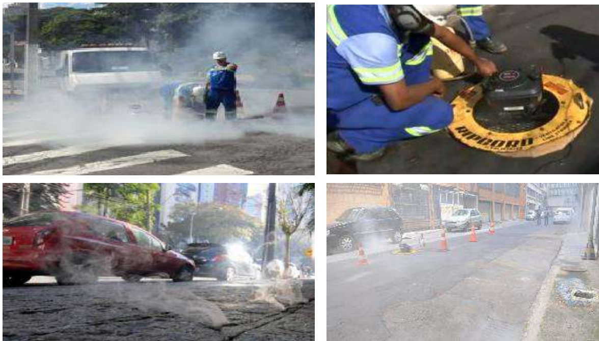
Figura 1: Realização do Teste de Fumaça.
