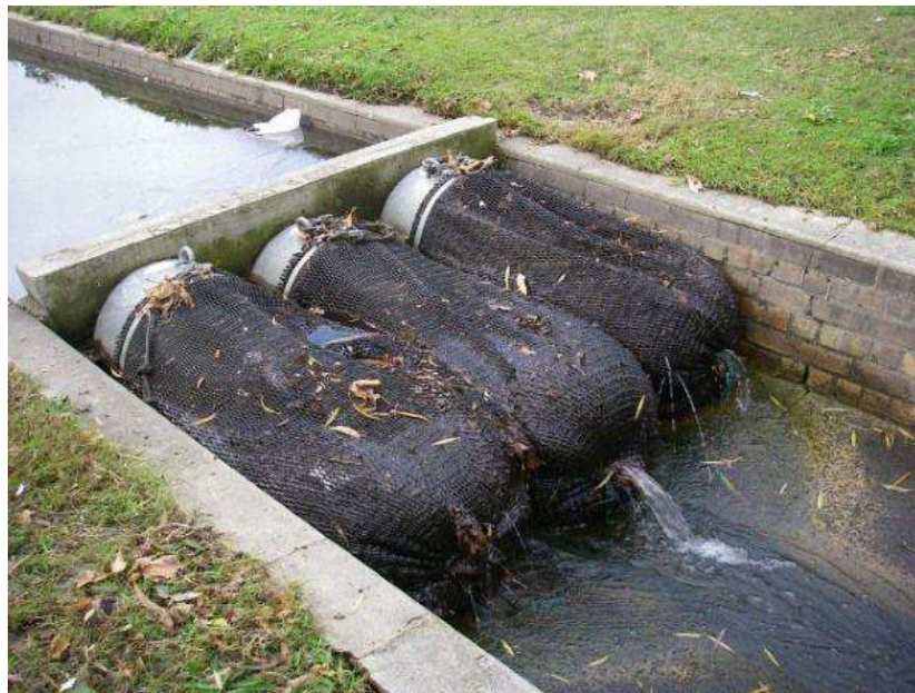
Figura 3: Rede posicionada na saída do tubo de drenagem que ajuda a capturar pequenos e grandes detritos.
