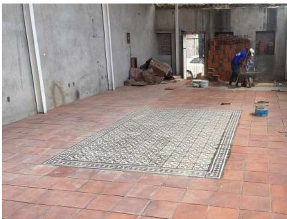
Figuras 47 e 48 - Instalação do piso do Salão Central e fechamento de parede lateral do Teatro Apolo.
