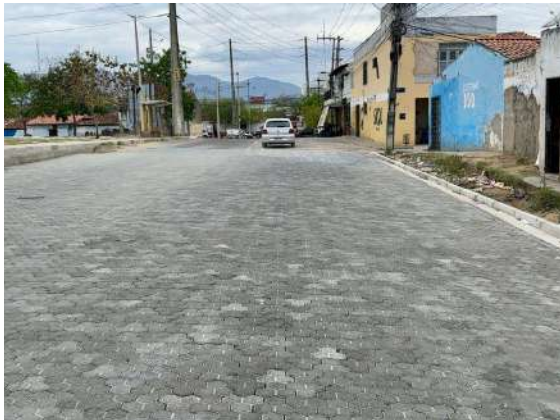
Figura 53 - Piso Intertravado no bairro Dom José.
