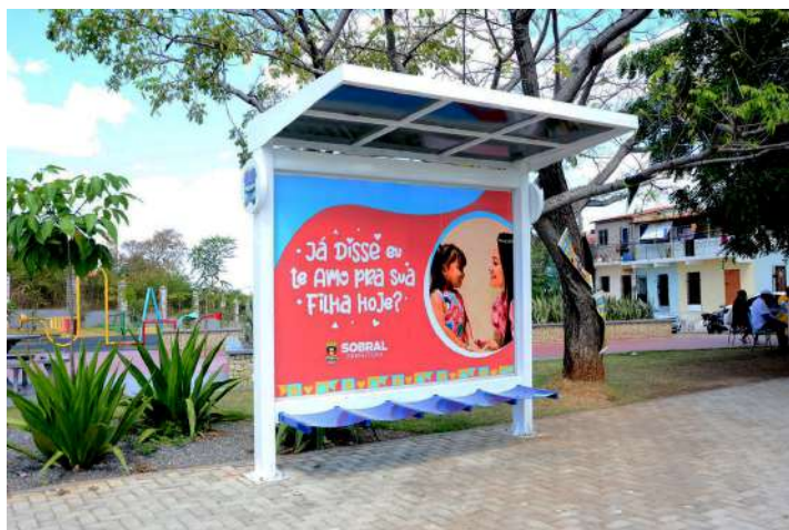
Figura 62 - Ponto de ônibus instalado na Praça do Jardim Botânico.
