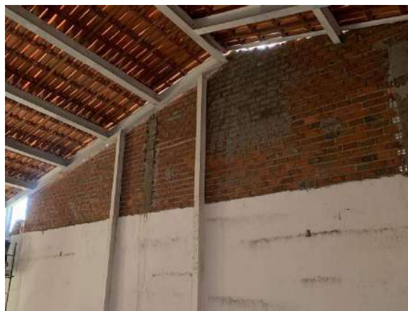
Figuras 47 e 48 - Instalação do piso do Salão Central e fechamento de parede lateral do Teatro Apolo.
