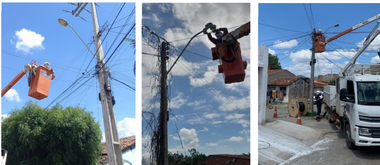
Figura 2 – Equipe da B&Q Energia atuando no serviço de manutenção de luminárias.
