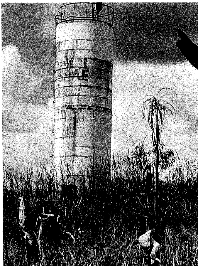
01 RESERVATÓRIO ELEVADO (REL) DA COMUNIDADE DE SÃO JOÃO
