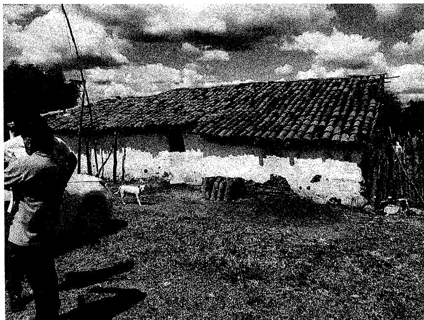
02 ÚLTIMA CASA ABASTECIDA PELO RESERVATÓRIO SÃO JOÃO
