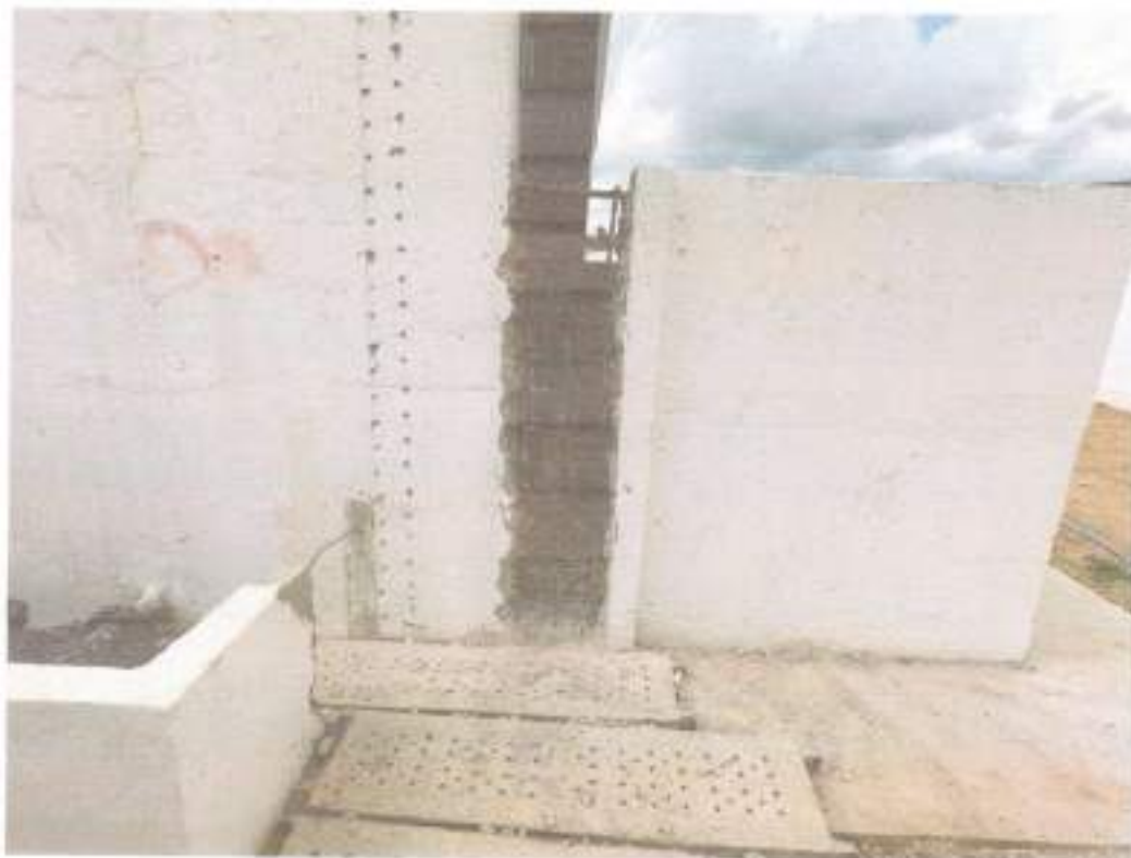
Figura 09 – Escarificação do concreto - ETE.
