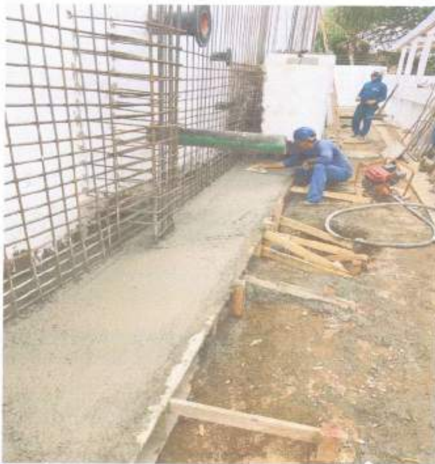
Figura 14 – Formas e concretagem do reforço estrutural - ETE.
