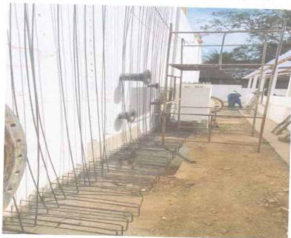
Figura 12 – Execução de armaduras complementares - ETE.
