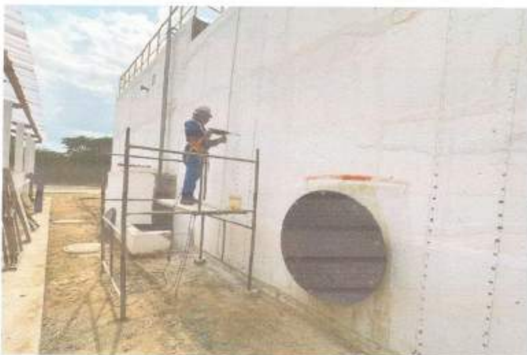
Figura 10 – Execução de furos para armaduras - ETE.
