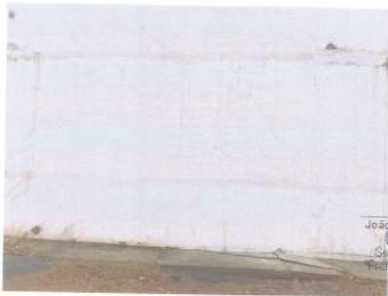
Figura 01 – Fissuração nos reatores UASB - ETE.
