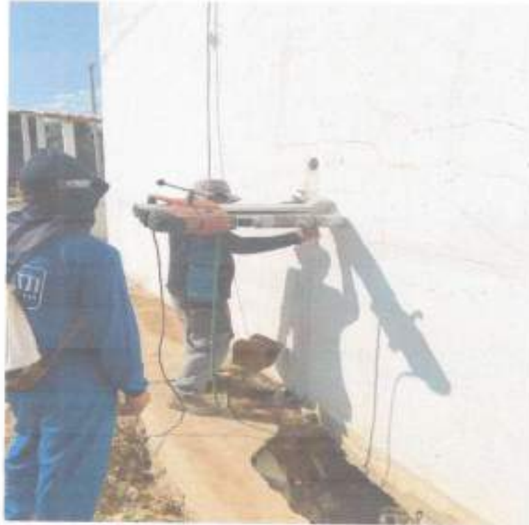
Figura 03 – Ensaio com testemunhos de concreto - ETE.
