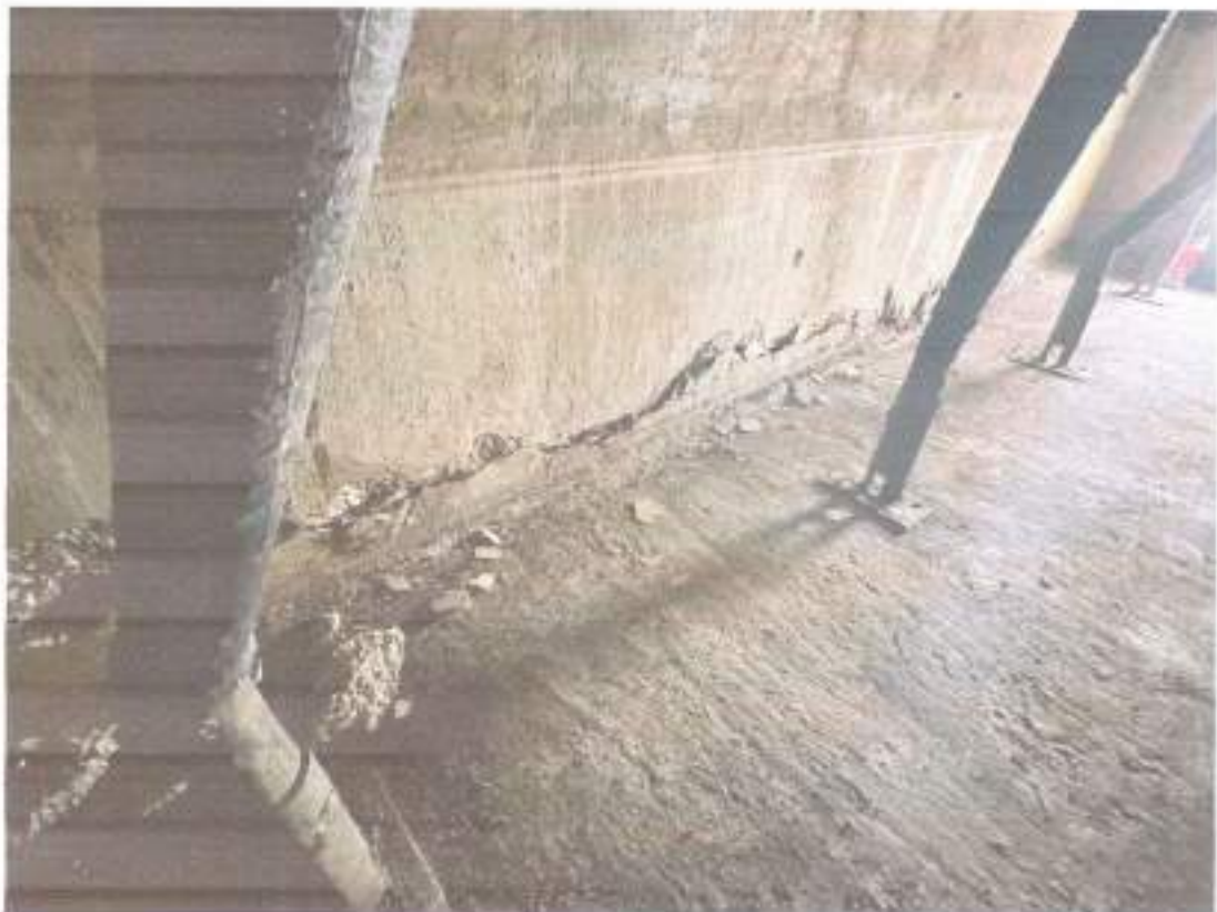
Figura 08 – Secagem e limpeza - ETE.
