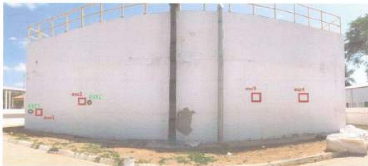
Figura 05 – Ensaios com Esclerômetro de reflexão- ETE.
