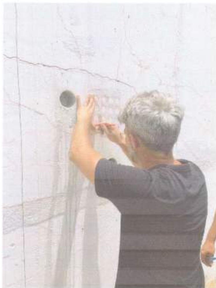
Figura 06 – Ensaios com Esclerômetro de reflexão - ETE.
