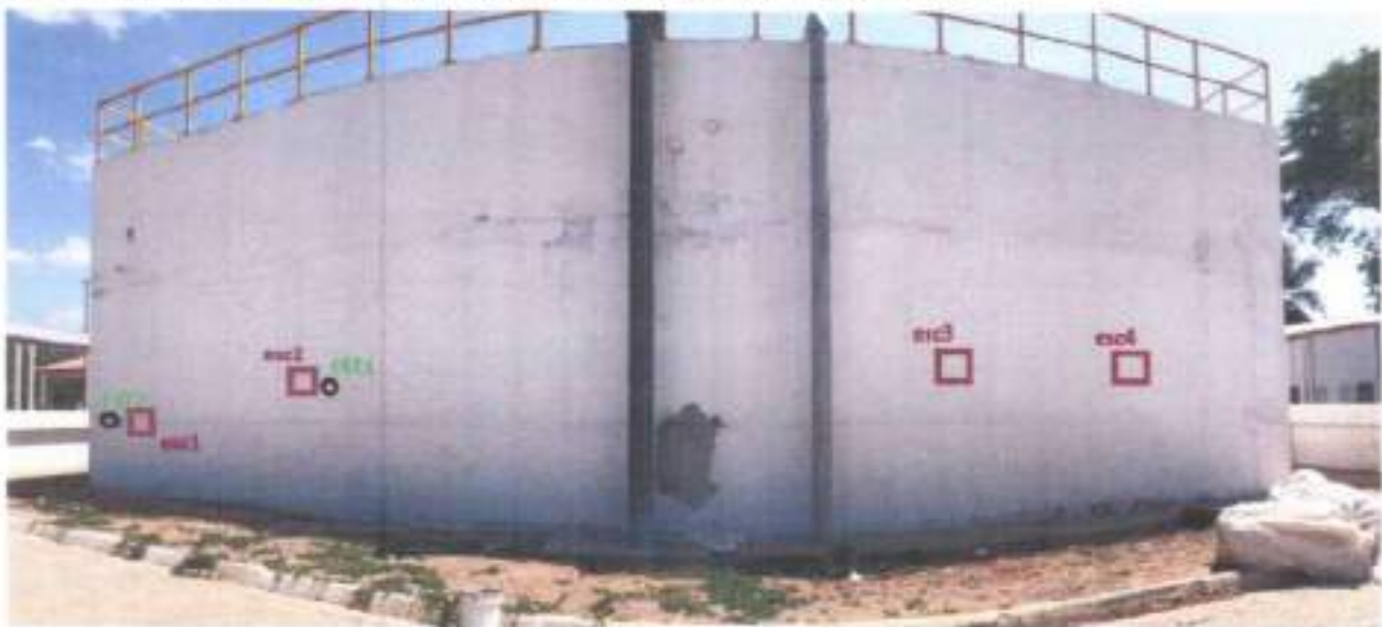
Figura 01 – Croqui dos locais e elementos avaliados.
