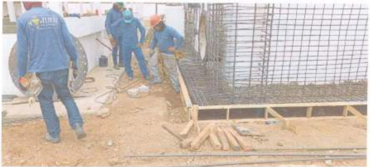
Figura 13 – Formas e concretagem do reforço estrutural - ETE.
