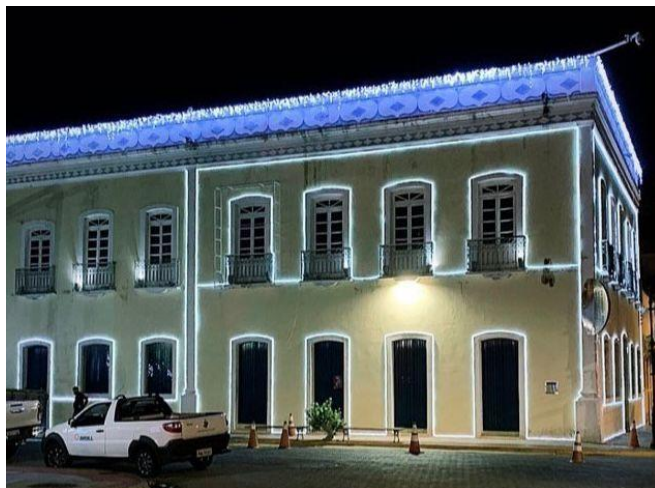
Figura 6 – Instalação de microlâmpadas e fitas de Led no palácio de línguas estrangeiras.
