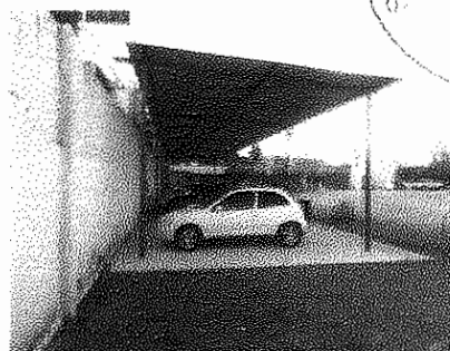
Foto 10: Edificação estrutura metálica
