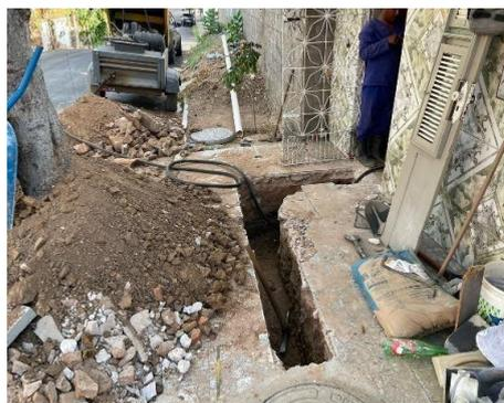
*Imagem 20 – Ampliação da rede de esgotamento sanitário do bairro Junco.*
