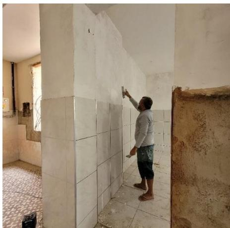
*Imagem 11 – Aplicação de revestimento cerâmico nos ambientes do pavimento superior.*
