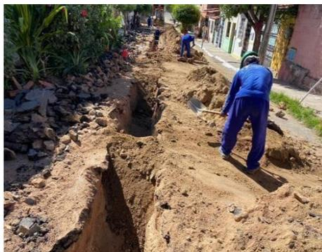
*Imagem 22 – Ampliação da rede de esgotamento sanitário do bairro Alto da Brasília.*
