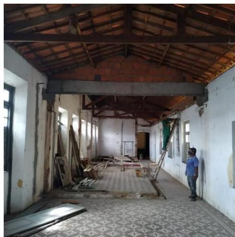
*Imagem 10 - Requalificação estrutural da cobertura no pavimento superior.*
