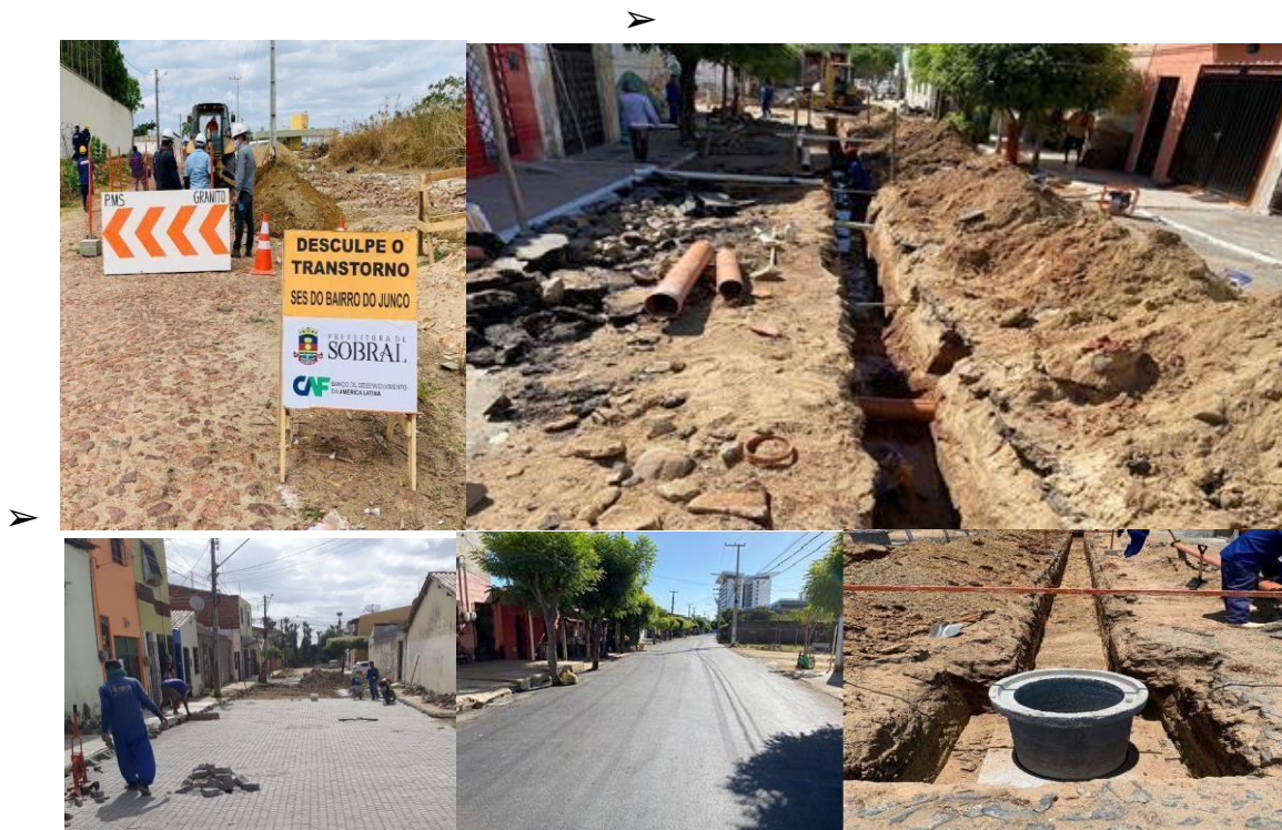
➤ Imagens 12, 13, 14, 15 e 16 - Obras de ampliação do Sistema de Esgotamento Sanitário
