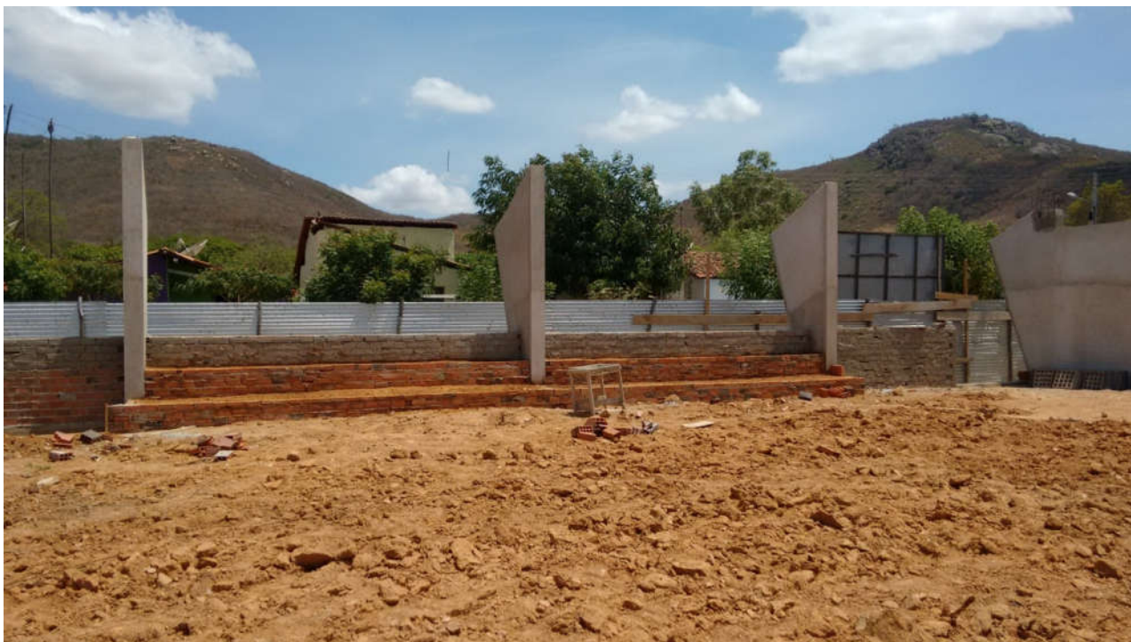
Figura 75: Quadra esportiva no distrito de Baracho
